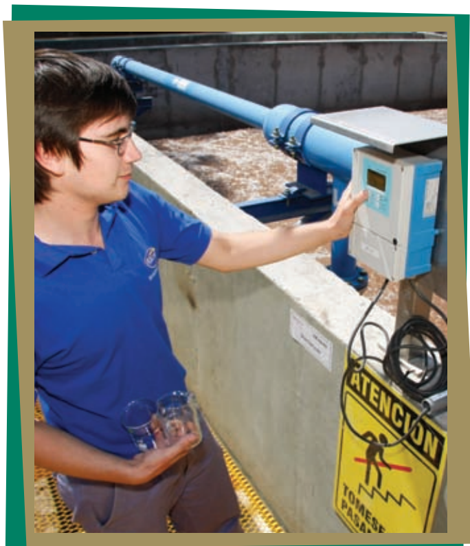
Planta de Tratamiento de Efluentes. Villa Krause, San Juan - Argentina.
