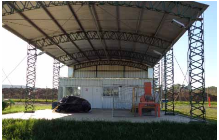
Área de acumulación temporaria de residuos
